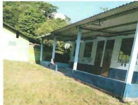
FOTO 2: SEGUIMIENTO DE LAMINAS Y ESTRUCTURA METALICA EN CORREDOR, COLOCACION DE BARANDAL, CAMBIO DE CHAPAS Y APLICACIÓN DE PINTURA A LAS AULAS
