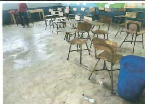
FOTO 4: CAMBIO DE PISO DE TORTA A PISO CERAMICO EN AULAS
