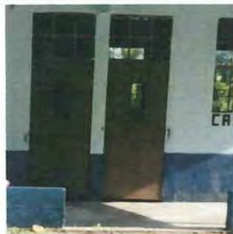
FOTO 8: MANTENIMIENTO DE PUERTAS DE AULAS, CAMBIO DE CHAPAS Y APLICACIÓN DE PINTURA
