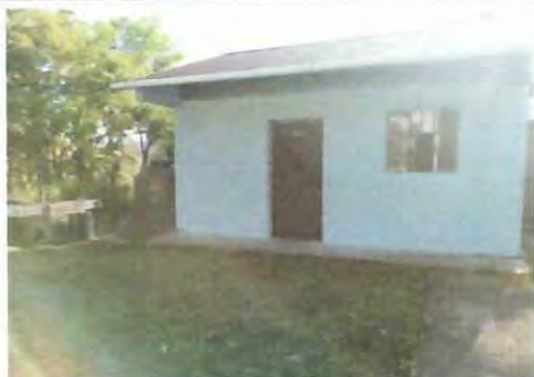
FOTO 1: CAMBIO DE LAMINAS Y ESTRUCTURA METALICA DE COCINA Y CORREDOR
