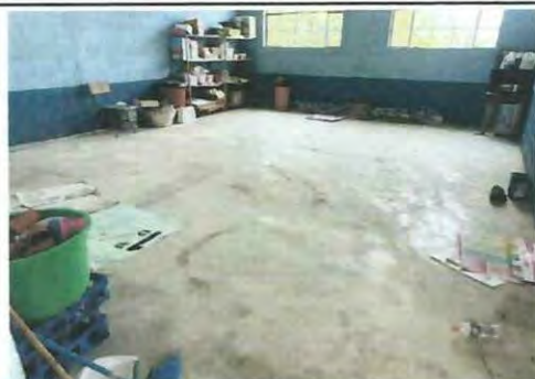
FOTO 3: CAMBIO DE PISO DE TORTA A PISO CERAMICO EN AULAS
