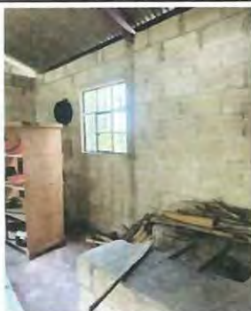
FOTO 9: MEJORAMIENTO DE POLLETON Y ELABORACION DE GABINETE EN COCINA, REPELLO, APLICACIÓN DE PINTURA Y CAMBIO DE PISO A PISO CERAMICO
