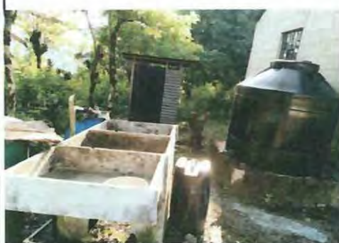
FOTO 7: MEJORAMIENTO DE SERVICIO SANITARIO Y PILA
